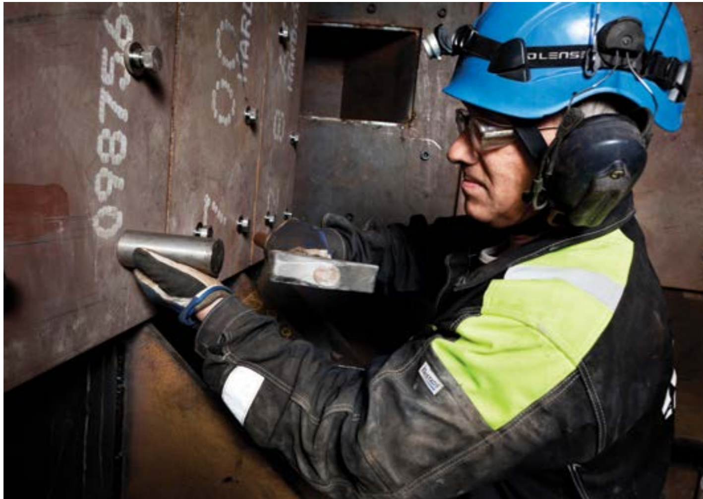
Montering av WRC Hylsskruv
